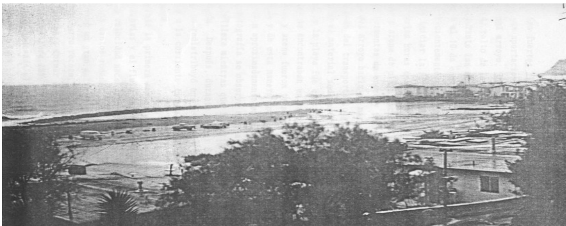
Fotografía 8.- Inundación de enero de 1978, tomada de Plaza-Flores (1979), vista de norte a sur.
