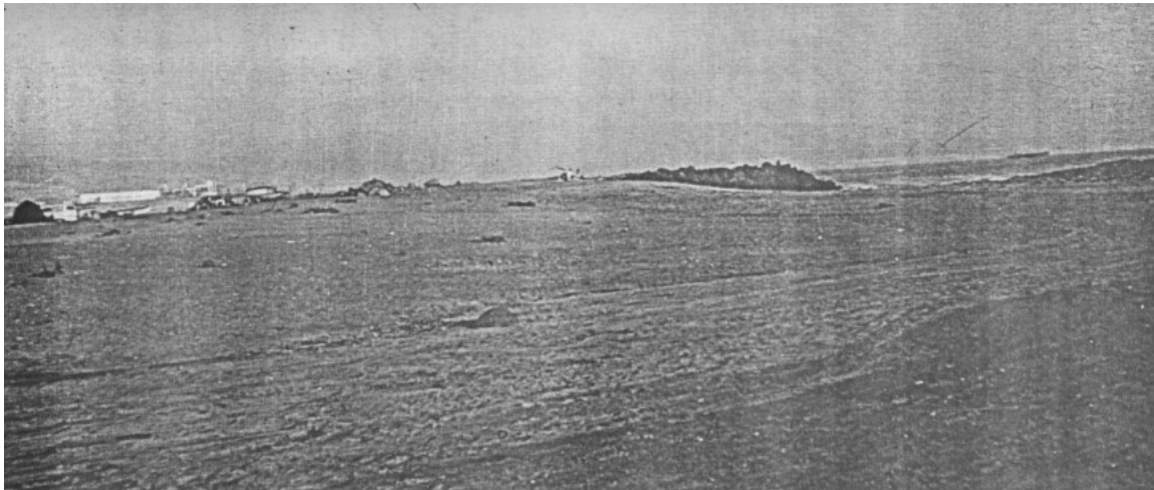
Fotografía 6.- Playa de San Miguel después del deslizamiento en octubre de 1977, tomada de Plaza-Flores (1979), vista oeste a este.
